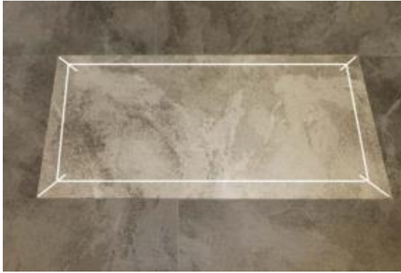
1. Element einschneiden und herausnehmen
